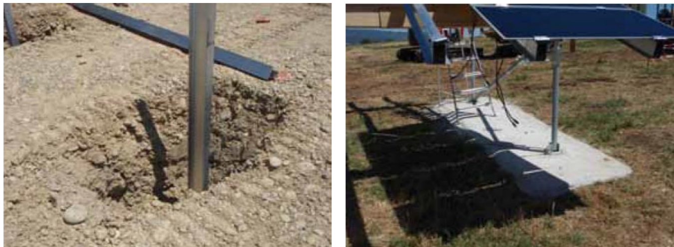
Photo 3 : Fondation avec pieux acier (à gauche) et fondation avec semelle béton (à droite)
