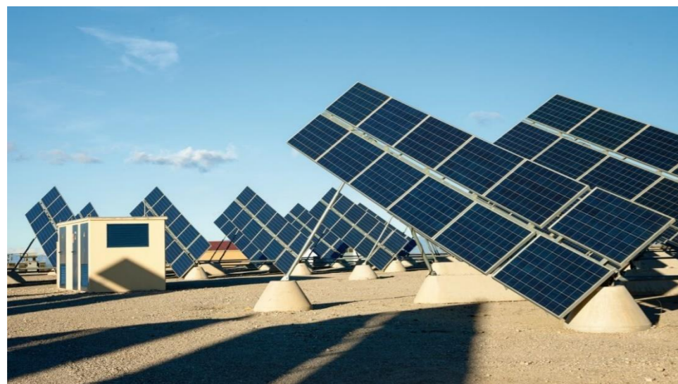
Figure 2 : Suiveurs à rotation bi-axiale (Source : PV Europe)
