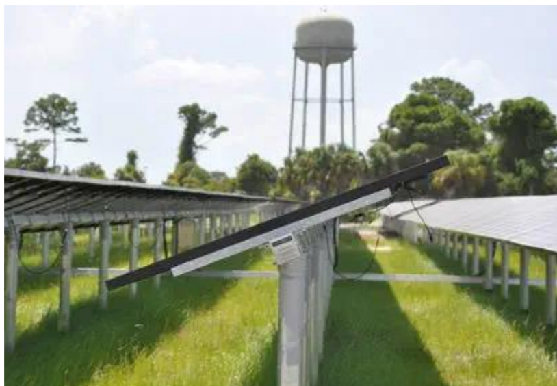
Figure 1 : Suiveurs à rotation mono-axiale (Source : DirectIndustry)
